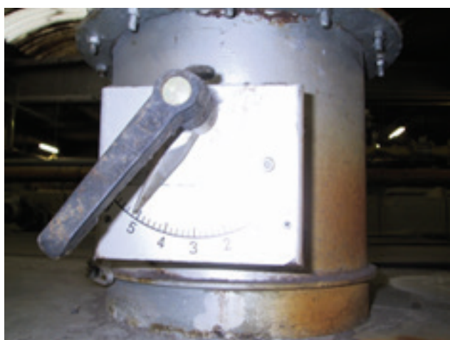
Exemples de positionnement de volets optimisés suivant des graduations
