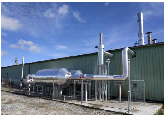
→ Modules Eco-stock® installés à côté de l'usine
