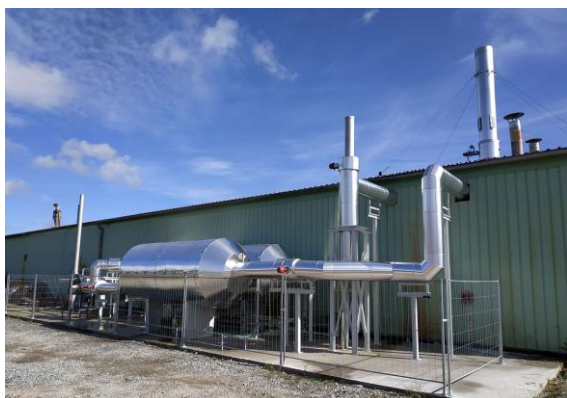
→ Modules Eco-stock® installés à côté de l'usine
